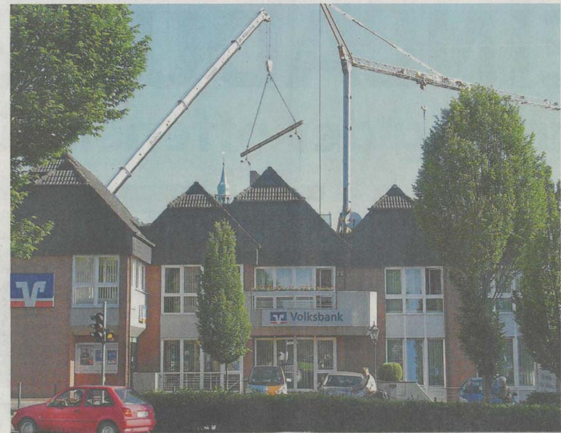
Ein Bild, das vielen Nottulnern wohl bekannt ist: Etliche Monate der Umbau- und Renovierungsarbeiten liegen hinter den Mitarbeitern und Kunden der Volksbank. Mit dem Ergebnis ist der Vorstand bestens zufrieden.
